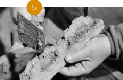
1. **Očistite ostatke betona s unutarnje strane kuta** ako ih ima prije nanošenja ljepila.
