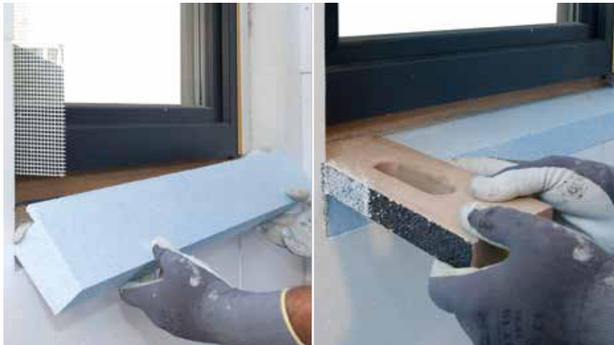
RÖFIX SOL-PAD priključni profil za prozorske klupčice ugraditi RÖFIX POLYMER-om i zatim premazati RÖFIX OPTIFLEX® 1K ili 2K izolacijskom masom za izravnavanje.
