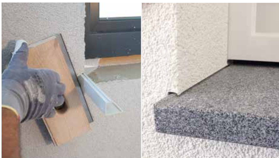
Rezanje viška RÖFIX SOL-PAD priključnog profila 2 mm od ruba i montaža prozorske klupčice.
