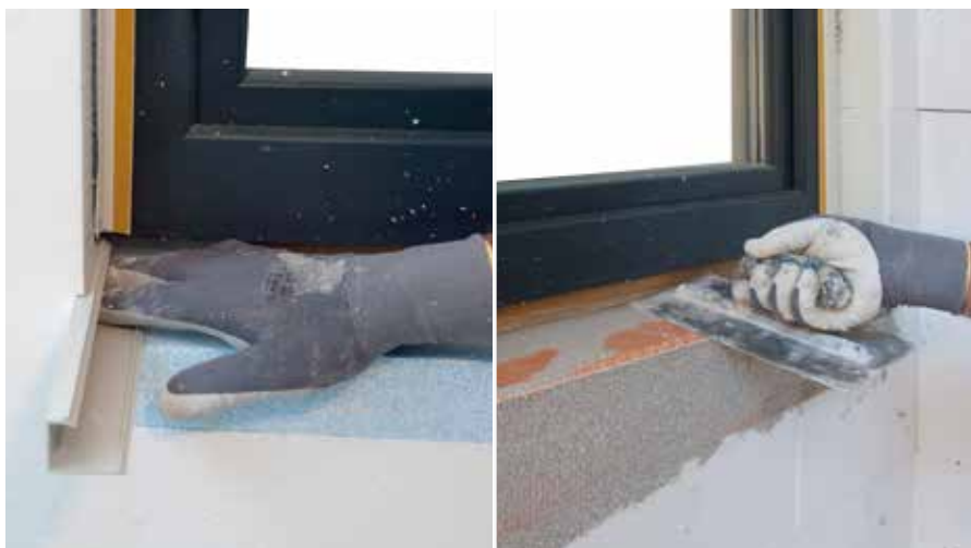
RÖFIX SOL-PAD priključni profil za prozorske klupčice zalijepiti RÖFIX POLYMER-om, zatim površinu izolirati s RÖFIX OTIFLEX® 1K ili 2K.
